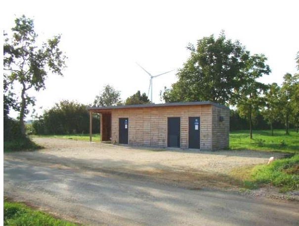
Figure 88 : Poste de livraison existant
