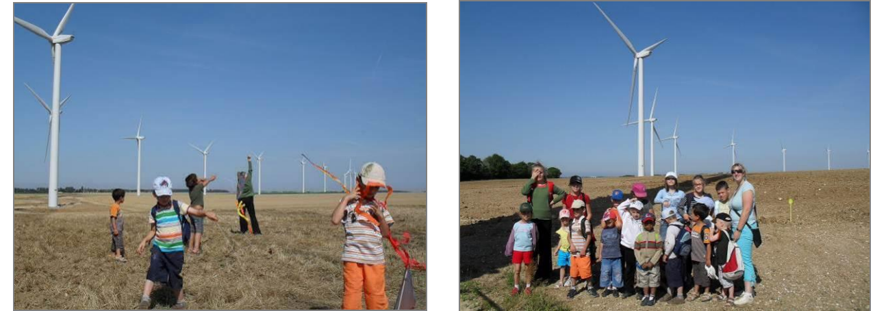
Visites du parc éolien du Chemin des Haguenets (Oise)
