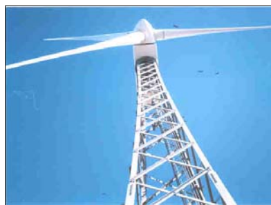
Photo 2 : Parc éolien d'Al Koudia Al Baida (Maroc) Survol de l'éolienne 73 par un groupe de Vautours Fauves ( Gyps fulvus ) à très basse altitude (A. El Ghazi - GOMAC, 2001)
