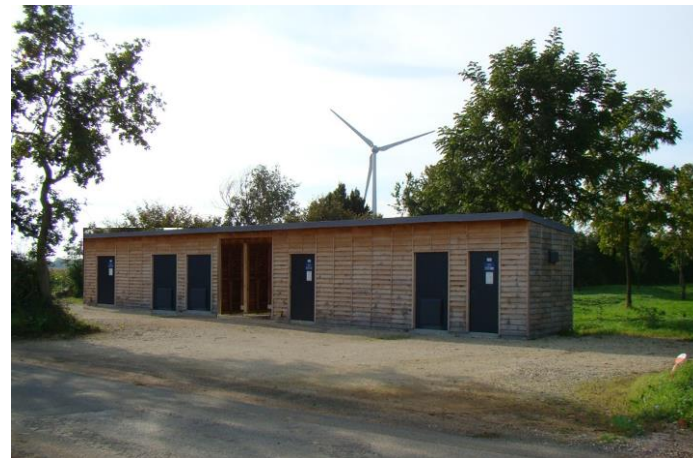
Figure 89 : Poste de livraison existant et deuxième poste de livraison
